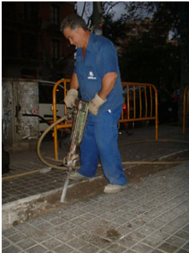
Fotografia 1: Rotura de les rajoles panot i la seva base de formigó amb martell pneumàtic.
