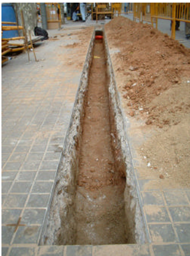
Fotografia 3: Vista parcial d'un tram de la Rasa 100.
