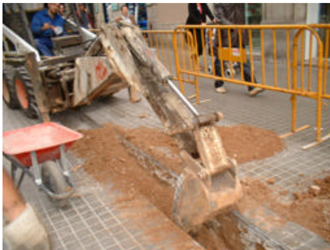
Fotografia 2: Buidatge del reompliment de les rases amb màquina retroexcavadora.
