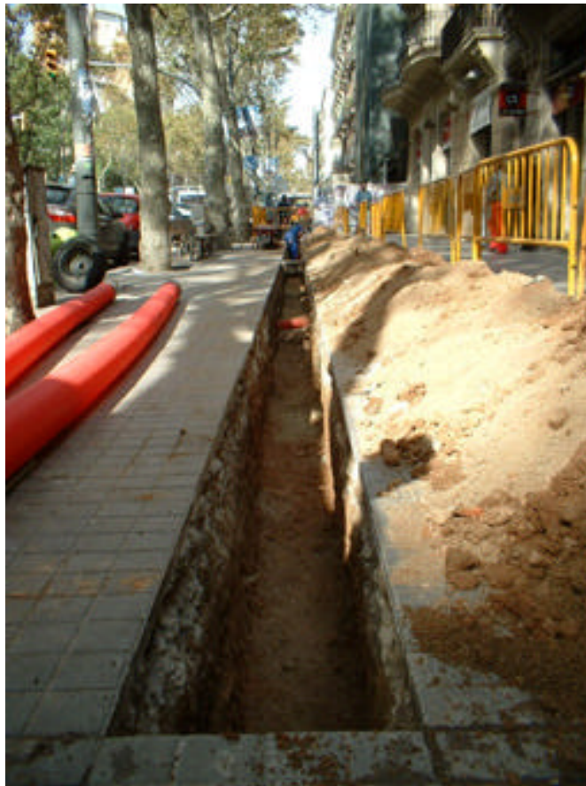
Fotografia 4: Vista general d'un altre tram de la Rasa 100.
